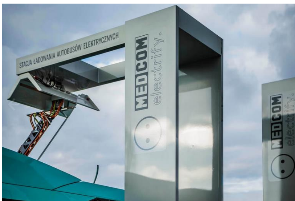
Rysunek 5. Pantografowe stacje ładowania dostarczone przez MEDCOM dla Jaworzna 38
